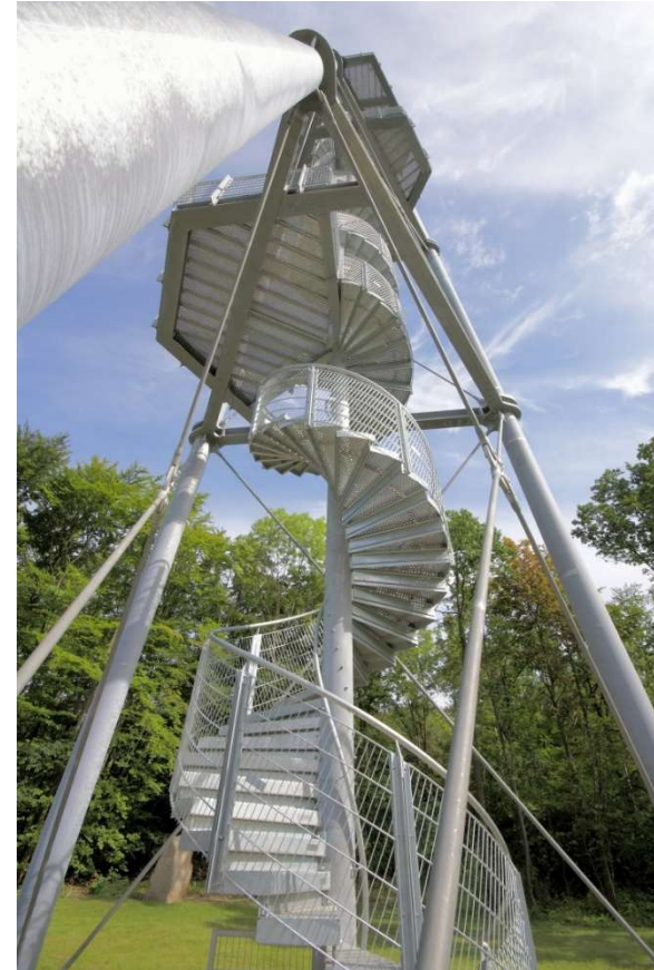
Eine verzinkte Stahltreppe – Bürgerturm Gotha
