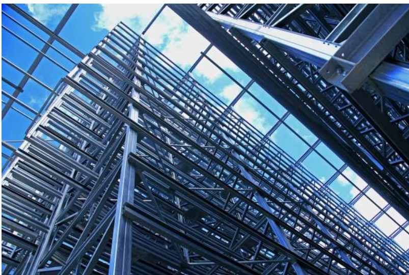
Stahlkonstruktion im Bau
