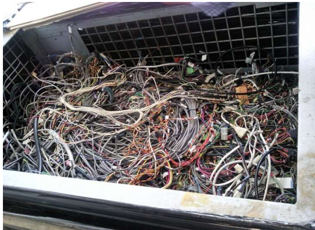
Alte Kabel aus Kupfer
